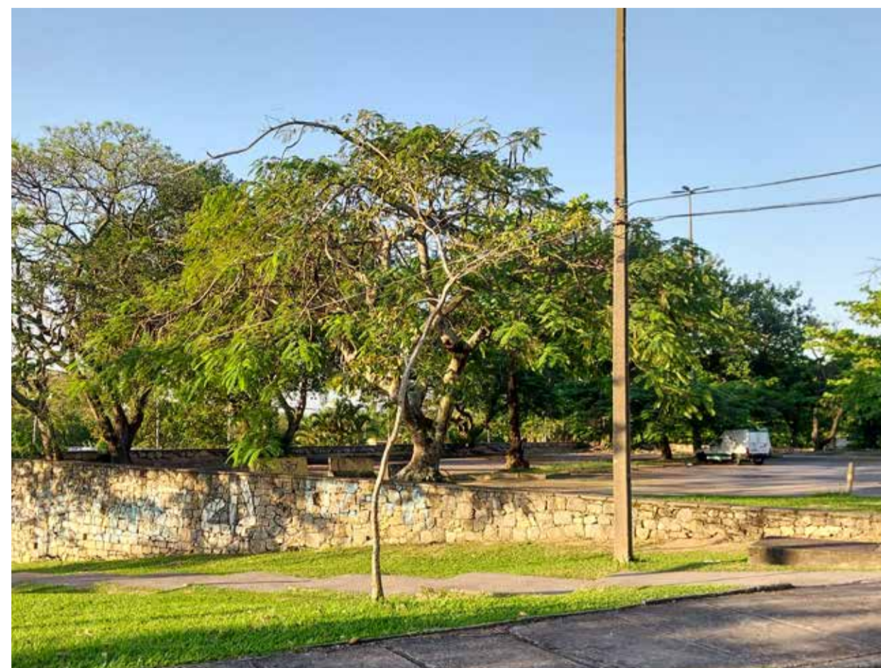
MENOS VAGAS parte da frente do estacionamento está fechada. Há risco de afundamento
