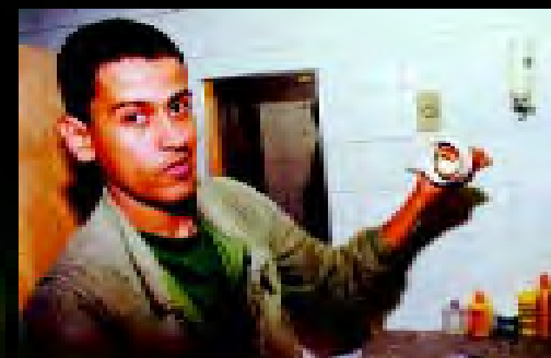
ESTUDANTE MOSTRA FILTRO CORROÍDO PELA ÁGUA DO ENCANAMENTO DO QUARTO
