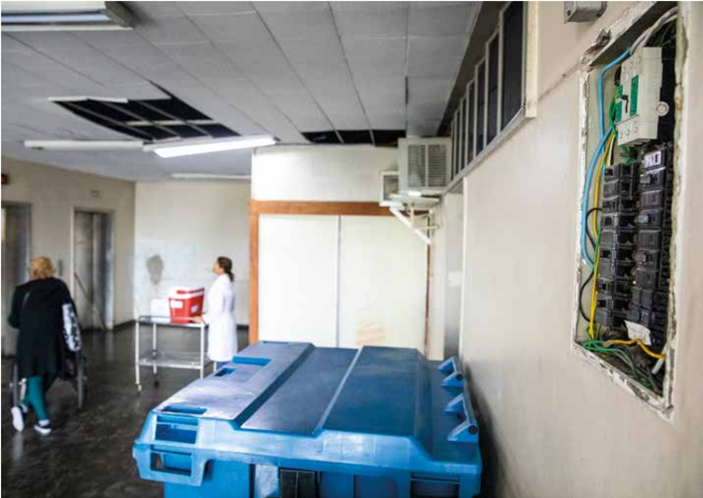
PERIGO Fiação exposta indica necessidade de reforma da rede elétrica no Hospital Universitário Clementino Fraga Filho. Pacientes demonstram preocupação com infraestrutura
