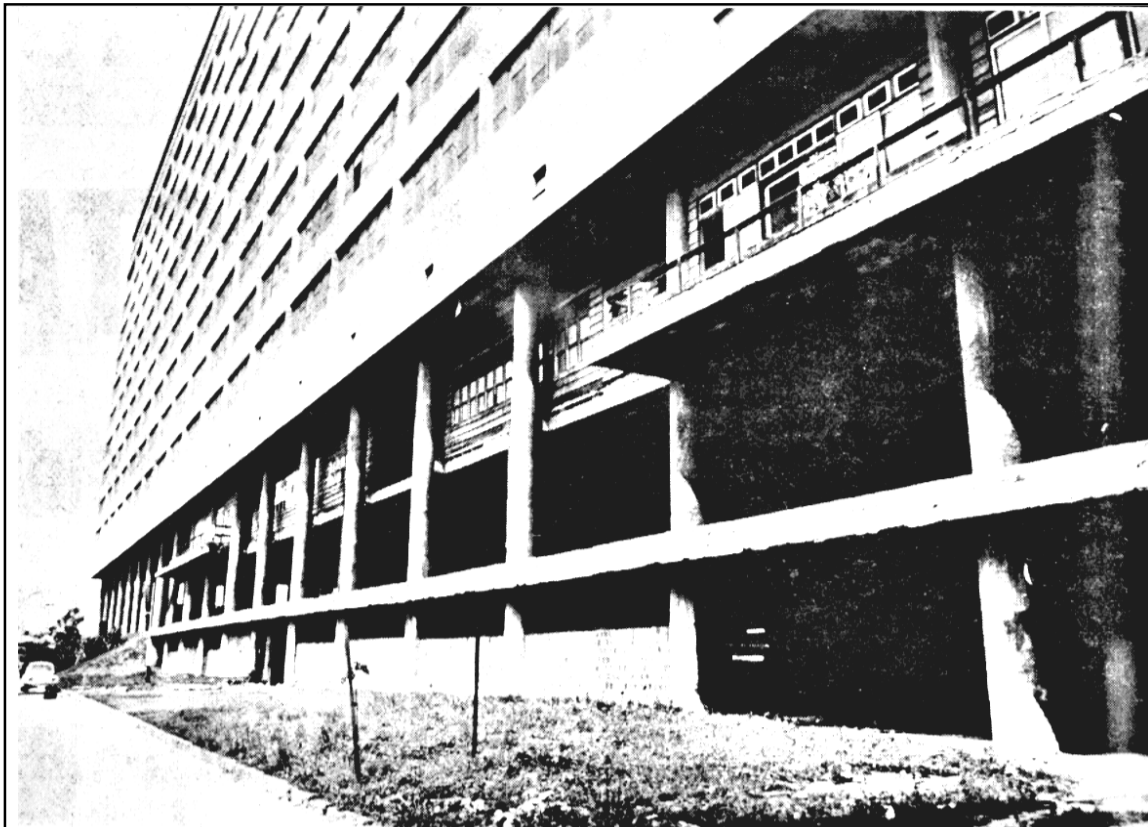
Para a metade não concluída do Hospital Universitário, no Fundão, já existiram até projetos de criação de um "centro de convivência". O Reitor Adolpho Polillo pretende terminar a construção do prédio e instalar Unidades do CCS.
