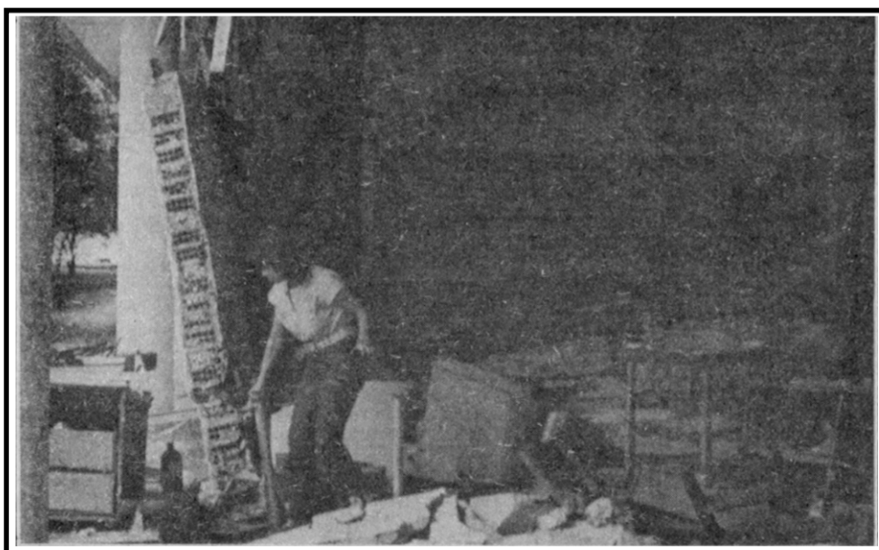
A parede lateral (que sobrou) do bloco E.
