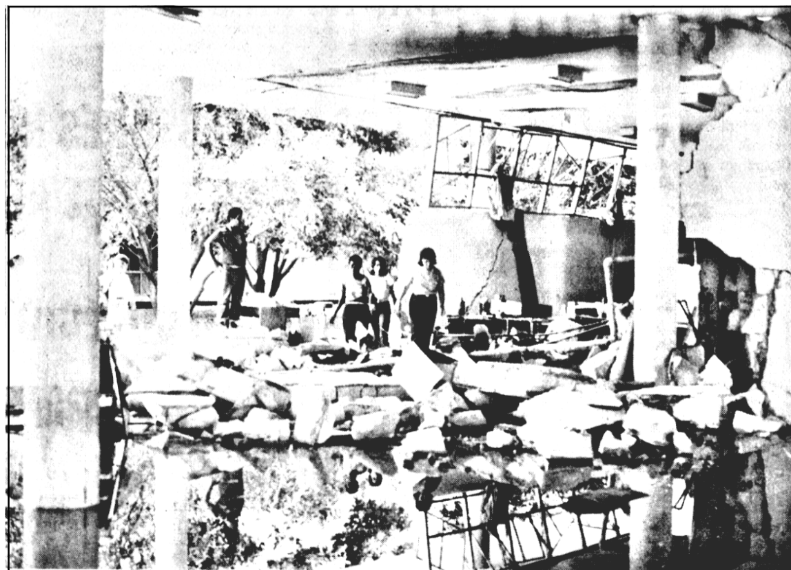
A falta de manutenção nos prédios pode provocar acidentes, como a explosão, por vazamento, nos fundos do bloco E do prédio do Centro de Tecnologia, ocorrido em 1984.
