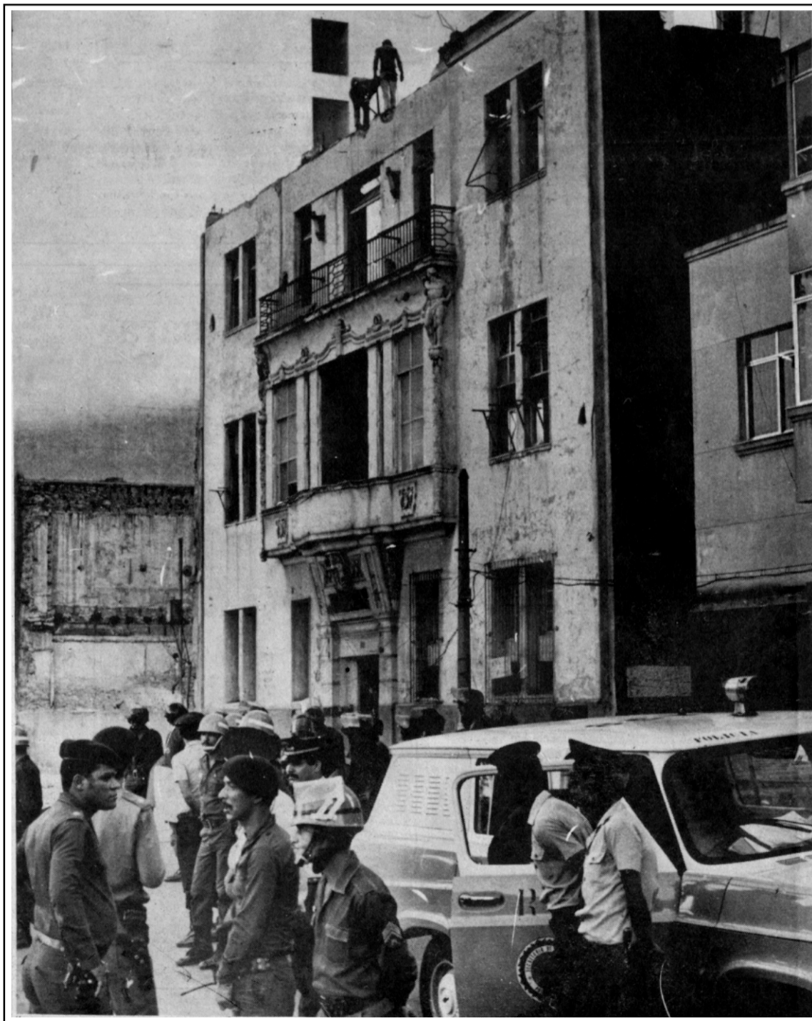
Demolição do prédio da UNE 1980
